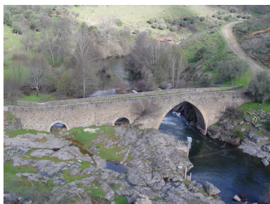
Foto 48 – Ponte Velha, freguesia de Pinelo
