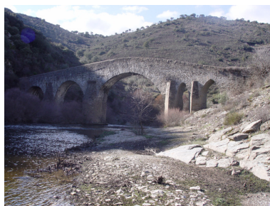
Foto 56 – Ponte de Santulhão, freguesia de Santulhão
