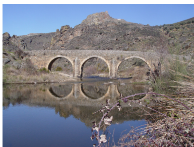
Foto 2 – Ponte de Algosó, freguesia de Algosó
