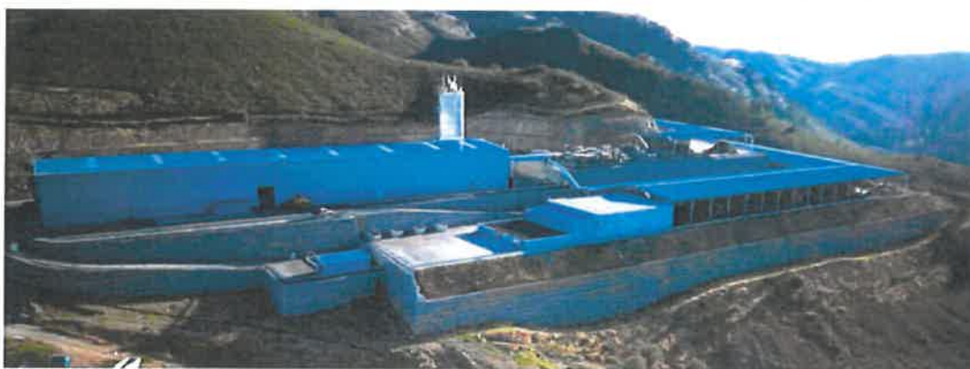
Figura 6 – Panorâmica Exterior da UTMB.
