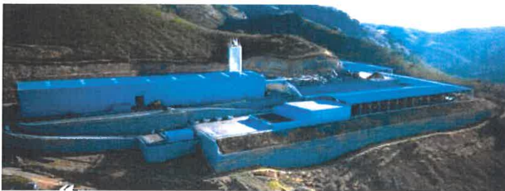
Figura 6 – Panorâmica Exterior da UTMB.
