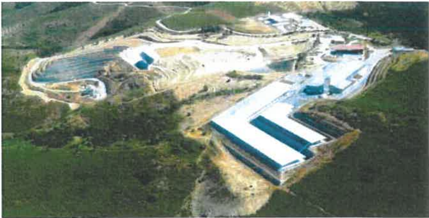
Figura 9 – Parque Ambiental do Nordeste Transmontano.
