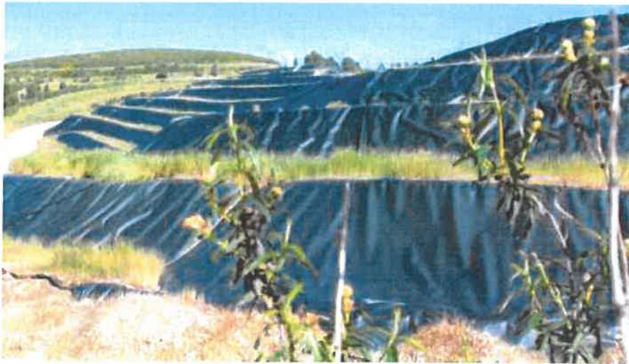
Figura 5 - Aterro Sanitário de Urjais – área selada.
