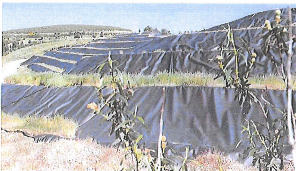
Figura 5 - Aterro Sanitário de Urjals – área selada.
