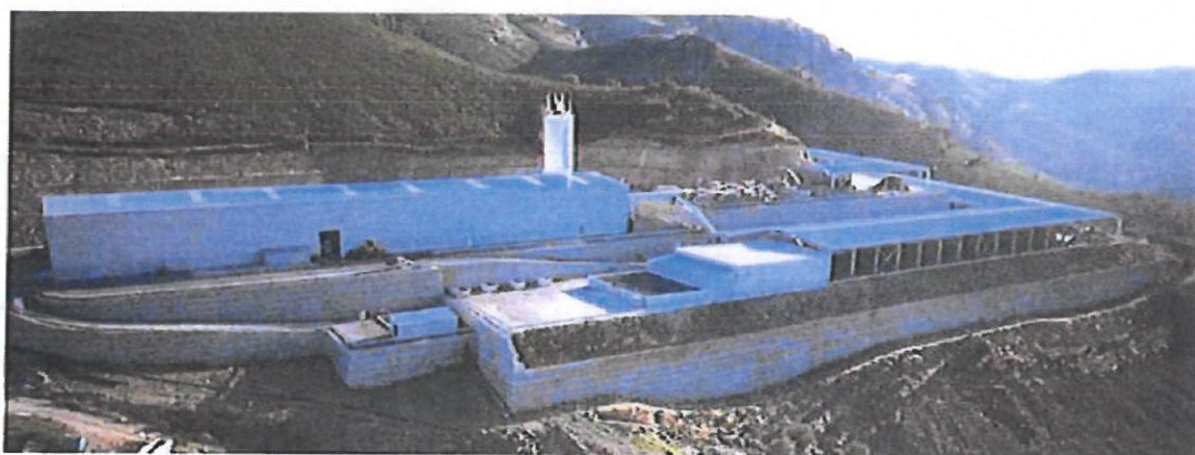
Figura 6 – Panorâmica Exterior da UTMB.
