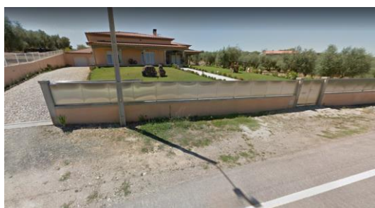
Inexistência de passeios na N317 junto a edificado residencial
