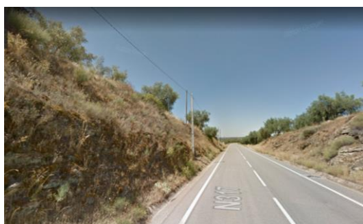
Inexistência de iluminação na N317, entrada sudoeste de Santulhão
