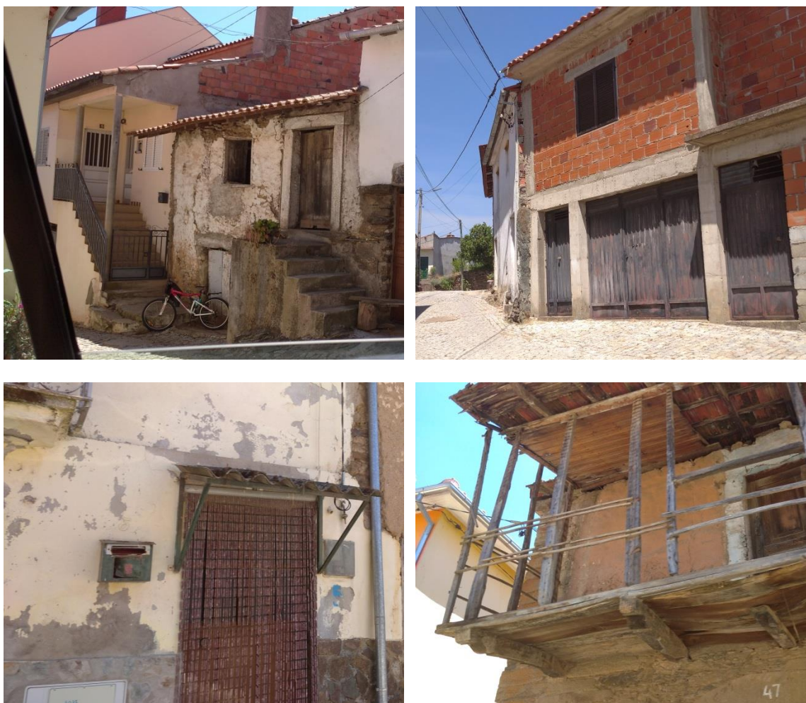
Figura 9. Habitações da aldeia de Santulhão
