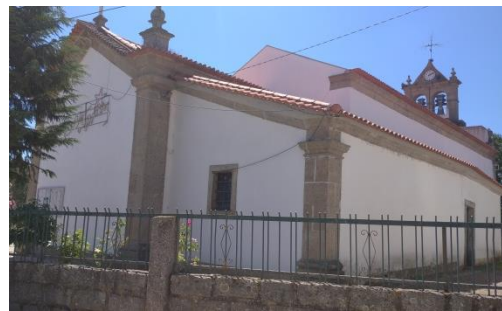
Igreja Matriz de Santulhão/ Igreja de São Julião
