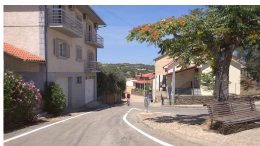
Inexistência de passeios na entrada oeste do aglomerado residencial de Santulhão
