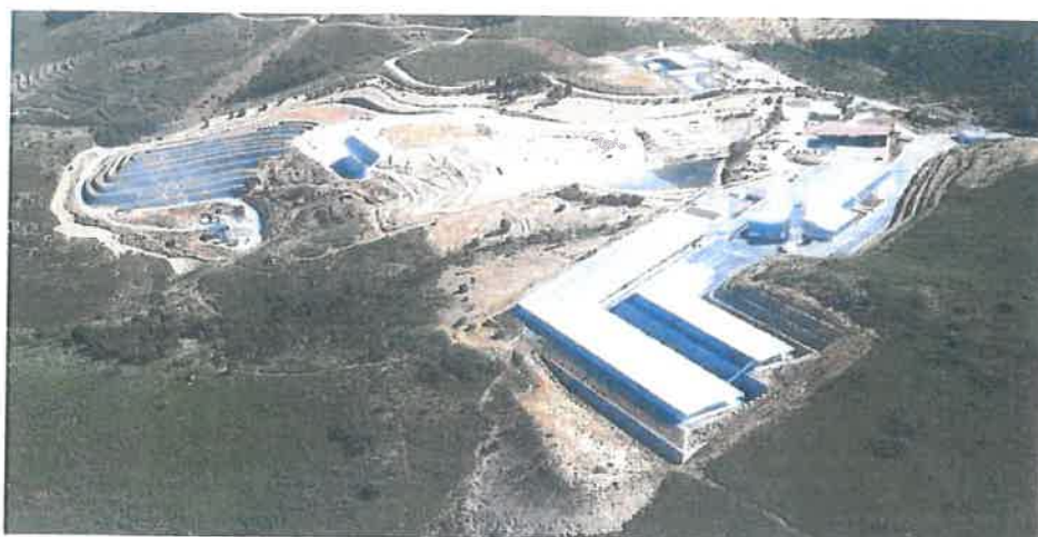
Fotografia 7 - Parque Ambiental do Nordeste Transmontano.
